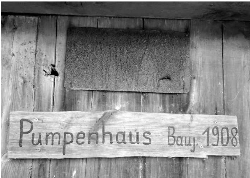
Im Pumpenhaus sind bis heute die Einschusslöcher sichtbar
